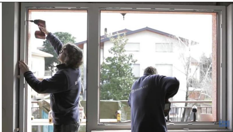
Esempio di sostituzione infissi
