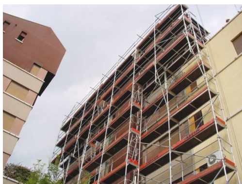
Esempio ponteggio su opere civili.
