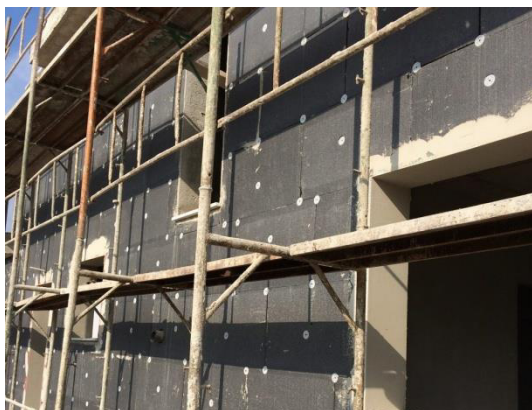
Esempio di realizzazione cappotto esterno e fasi di realizzazione
