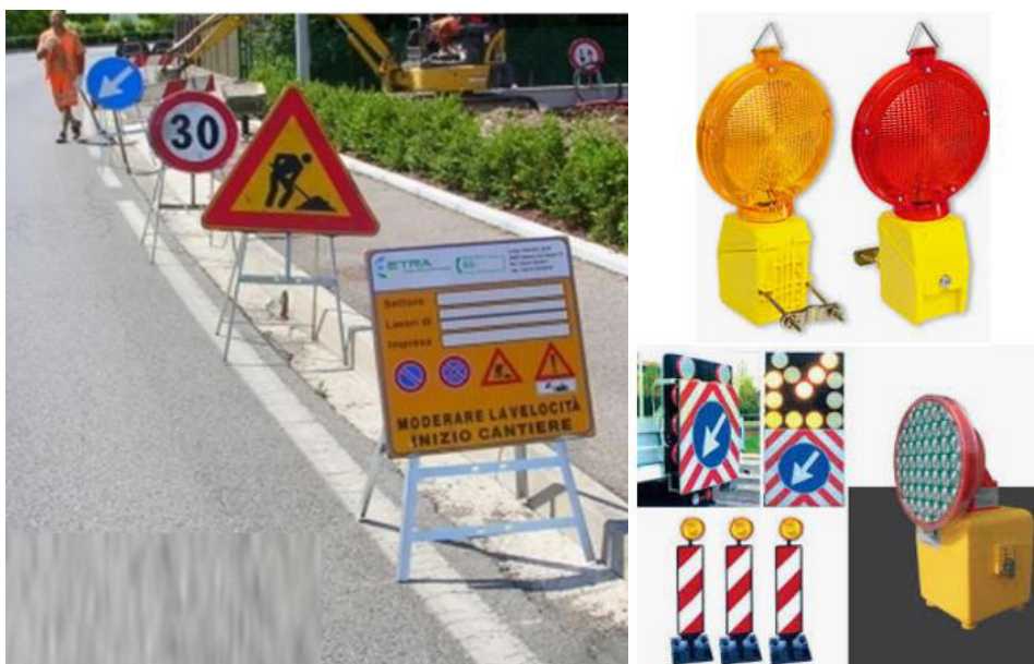
Segnalazione cantiere/ illuminazione notturna
