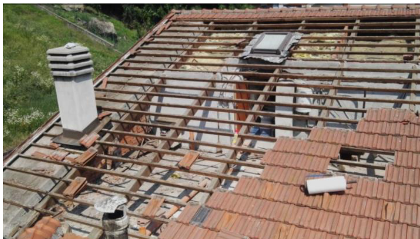
Esempi di demolizione manto di copertura
