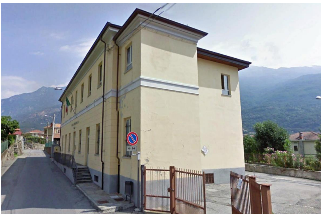
Edificio oggetto di intervento
