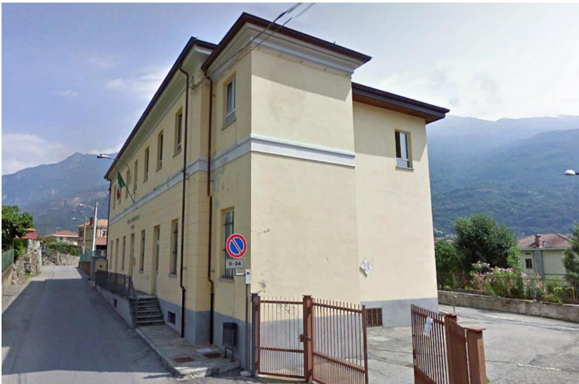
Struttura oggetto di intervento
