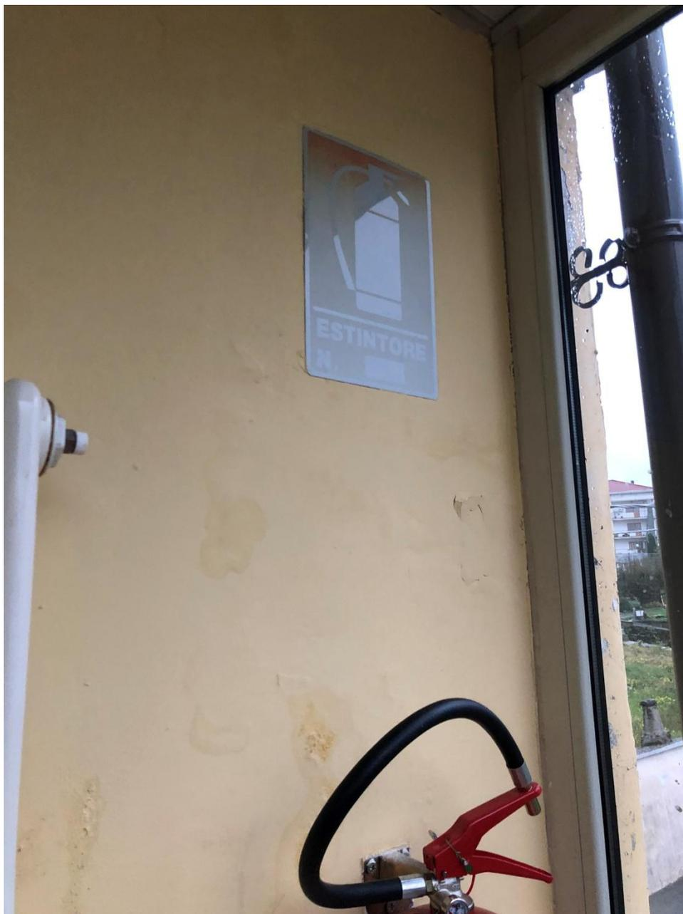
Figura 13 - Dettaglio macchie infiltrazioni zona nord
